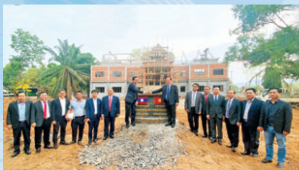
Đoàn đại biểu tỉnh Bình Định và lãnh đạo tỉnh Sekong thăm công trình hữu nghị Trụ sở Sở Ngoại vụ tỉnh Sekong, Lào do tỉnh Bình Định tài trợ vốn
