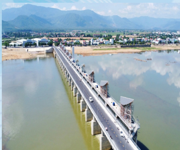
Đập dâng Phú Phong (huyện Tây Sơn) cung cấp nước tưới, cải thiện môi trường và phát điện
